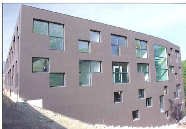
Collège de Genolier: le découpage irrégulier des ouvertures se retrouve sur les quatre façades.
