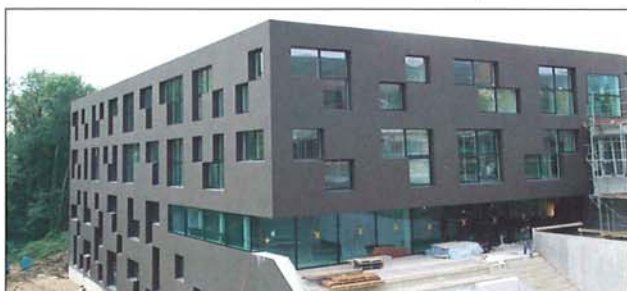
Vue générale de l'extension du collège secondaire de Genolier, réalisé en béton apparent auto-compactant avec du ciment Flexremo 3R (photo Holcim).
