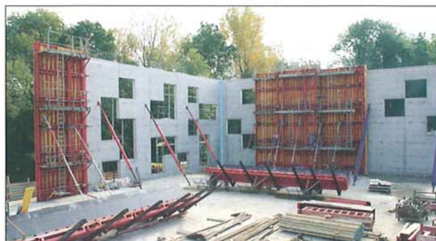
Collège secondaire de Genolier: il s'agissait de procéder au bétonnage de segments de murs de 8 m de haut dans une première étape, puis de 7 m dans une seconde, sans se préoccuper outre mesure des ouvertures de façade parfois très larges entravant le passage du béton (photo Holcim).
