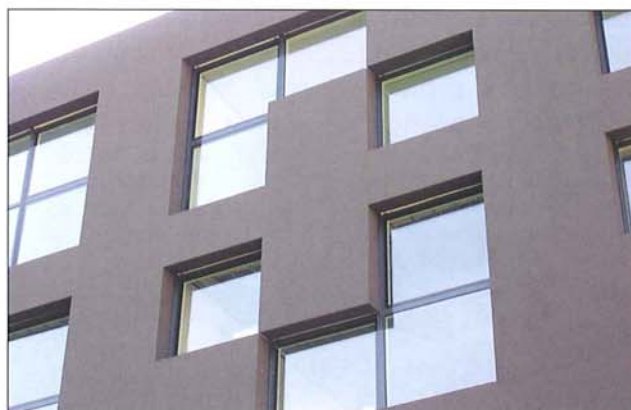
Les fenêtres percent de manière aléatoire la façade en béton armé.
