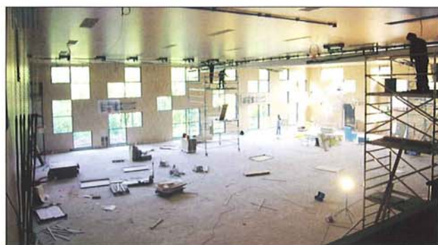
Collège de Genolier: la salle multisports occupe toute la largeur du bâtiment sur plus des deux tiers de la longueur, soit 32 m x 32 m, et une hauteur de 8 m.
